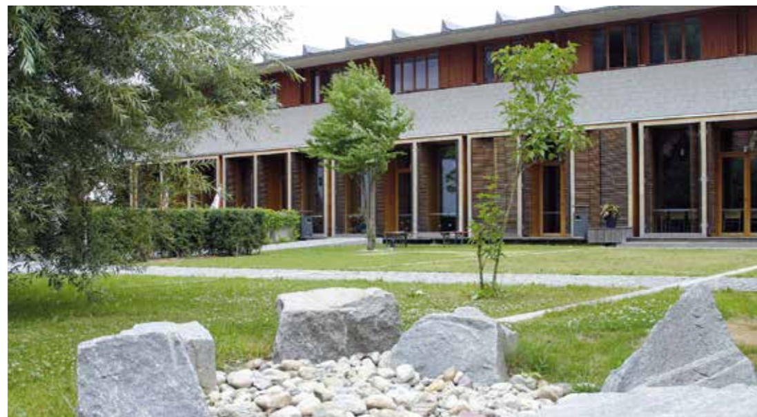
» Pohled ze zahrady na ubytovnu mládeže Dachau, © MMSZ Dachau
